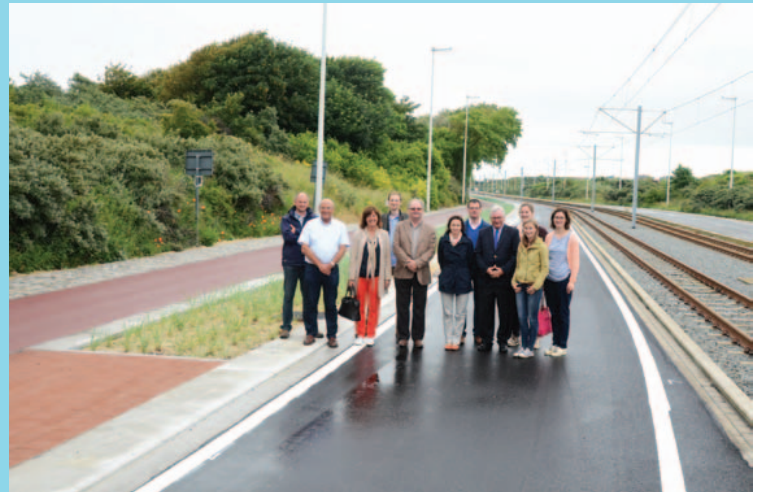
De eerste fase (noordkant) van de vernieuwde Albert I-laan tussen Groenendijk en Oostduinkerke-Bad werd vòòr de zomer voor het verkeer opengesteld.
