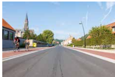
>> Kerkstraat in een nieuw jasje
