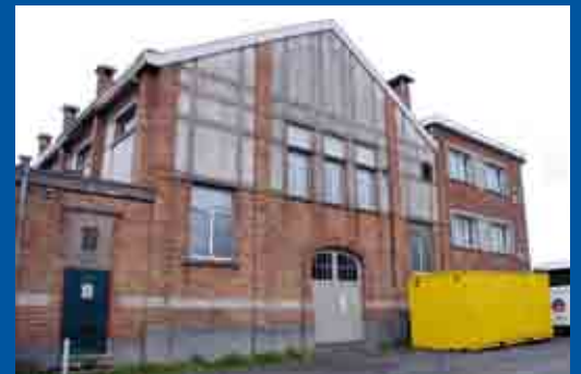
Oud tramgebouw van De Lijn, Dorlodotlaan in Koksijde
