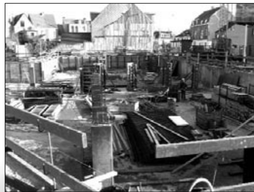
De bouwput op de hoek van het Hegerplein en de Vandammestraat waar de Veurnse Bouwmaatschappij 32 nieuwe sociale appartementen zal oprichten.
